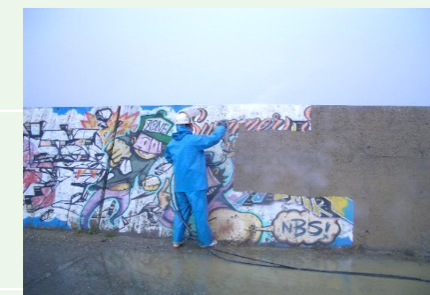
塗膜剥離・落書き除去工事
