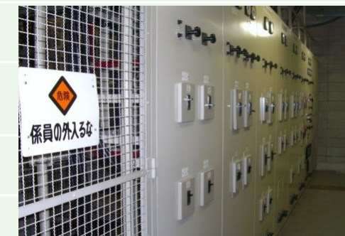
電気設備改修工事
