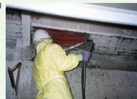
アスベスト対策工事
