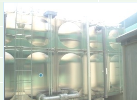
給排水設備工事
