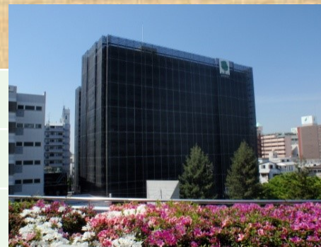
大規模修繕工事
