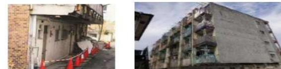
（建物の傷みが著しく外壁の剥落等が生じた事例）
